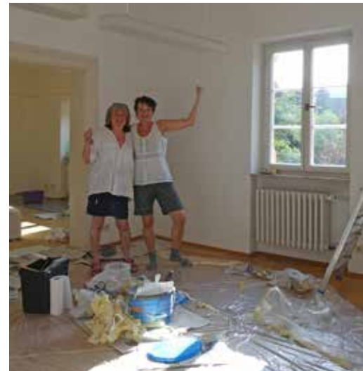
Renovierungsarbeiten in den oberen Räumen der Villa Menzer von Annette Blaschke (li) und Beate Meffert-Schmengler (re) Foto: Beate Meffert-Schmengler
